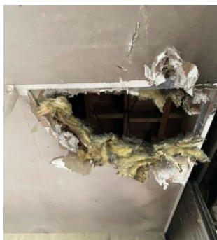
Etat de dégradation plaque de plâtre des gaines aile sud sinistré
