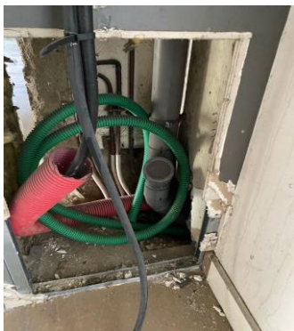
Etat de dégradation plaque de plâtre des gaines aile sud sinistré
