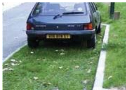
Dalle végétalisée béton convenant au passage des automobiles
