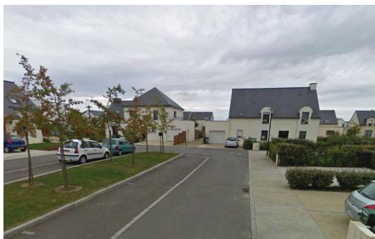
Traitement d'une impasse en placette, prolongée par un cheminement piétonnier. Plantations centrales, stationnement latéral. Chaussée étroite. Déplacement piétonnier marqué un revêtement plus clair. Le Rheu (35).
