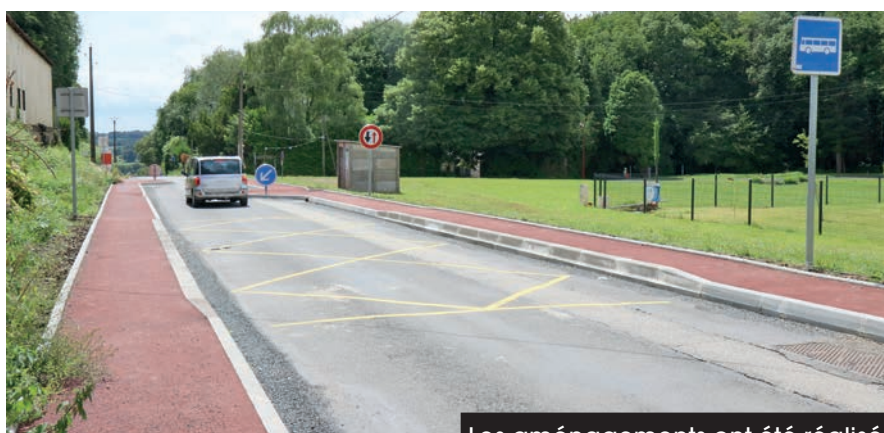
Les aménagements ont été réalisés à l'entrée de la commune.
