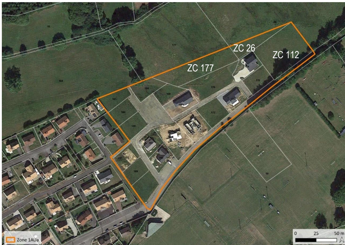
Situation de la zone 1AUa et vue aérienne
