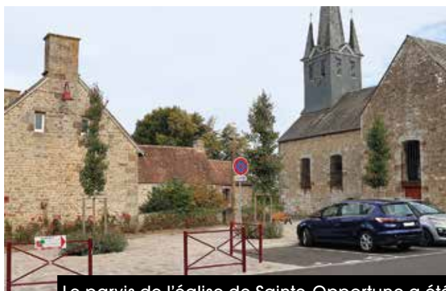
Le parvis de l'église de Sainte-Opportune a été repavé dans le cadre des travaux d'aménagement.
