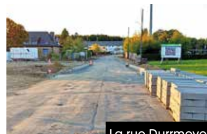
La rue Durrmeyer en travaux en octobre.
