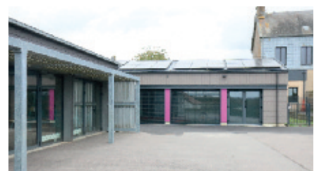
La nouvelle salle de motricité, à l'école de Landisacq, remplace l'ancien préfabriqué.
