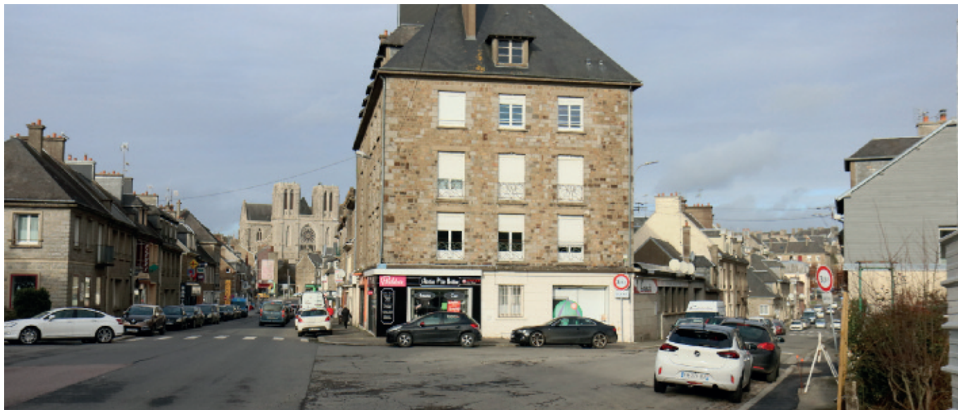
Les travaux place du 14-Juillet devraient se terminer à la fin de l'année 2024.
