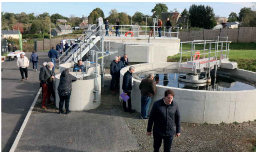
La station d'épuration et le réseau d'assainissement collectif ont coûté près de 2,8 millions d'euros.
