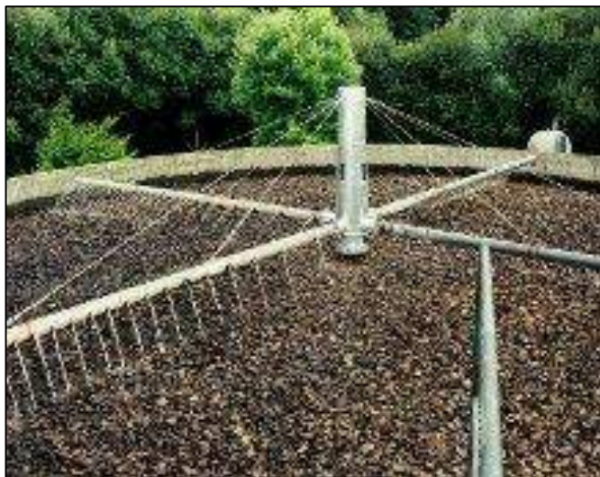
Schéma et photo d'un lit bactérien alimenté par sprinkler
