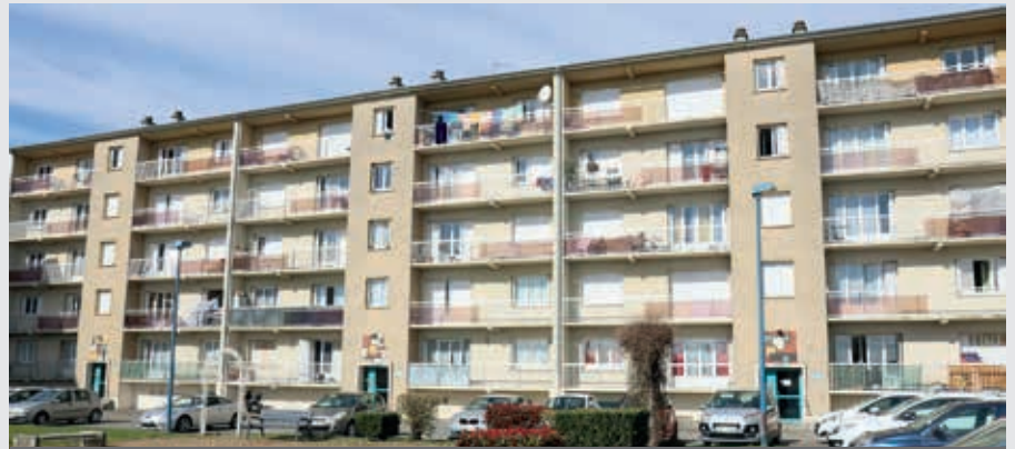
La résidence Foucault compte trois immeubles.
