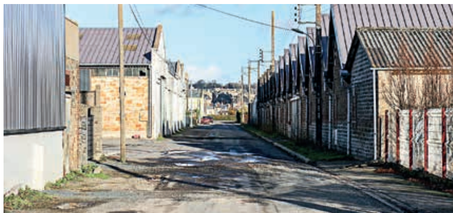
Les travaux d'aménagement se poursuivent avec l'enfouissement des réseaux rues du Parc et de La Fonderie.
