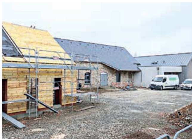
La salle du Rex lors des travaux, à la fin du mois de décembre 2022.
