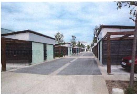
*Réduction de la largeur de la chaussée, caniveau central, aménagement de traversées qui ponctuent la rue, ouverture des garages directement sur la chaussée ;*
