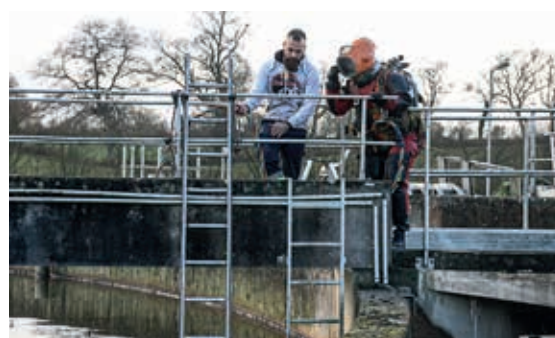
Des scaphandriers ont nettoyé les bassins de la station du Landis, des déchets imputrescibles.
