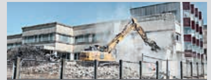
Les travaux ont commencé en mars à l'usine Faurecia du Bois de Flers.
