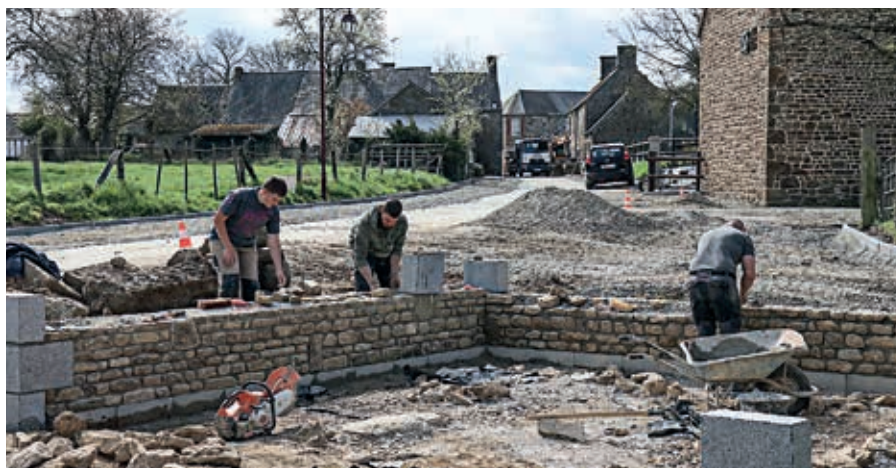
L'aménagement du bourg a été l'occasion, notamment, de réhabiliter le lavoir.
