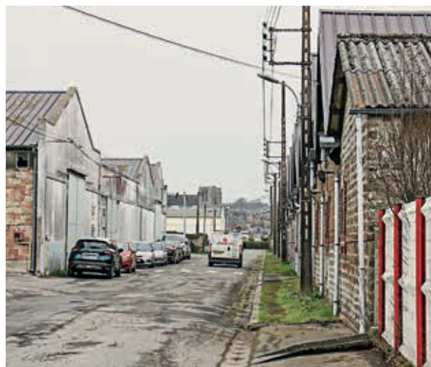
Les travaux vont débiter par la rue du Parc, dès ce mois de juin.
