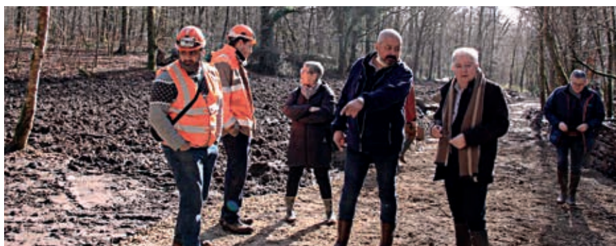
Élus et techniciens se sont rendus sur place le 25 février, à la fin des travaux de mise en sécurité.
