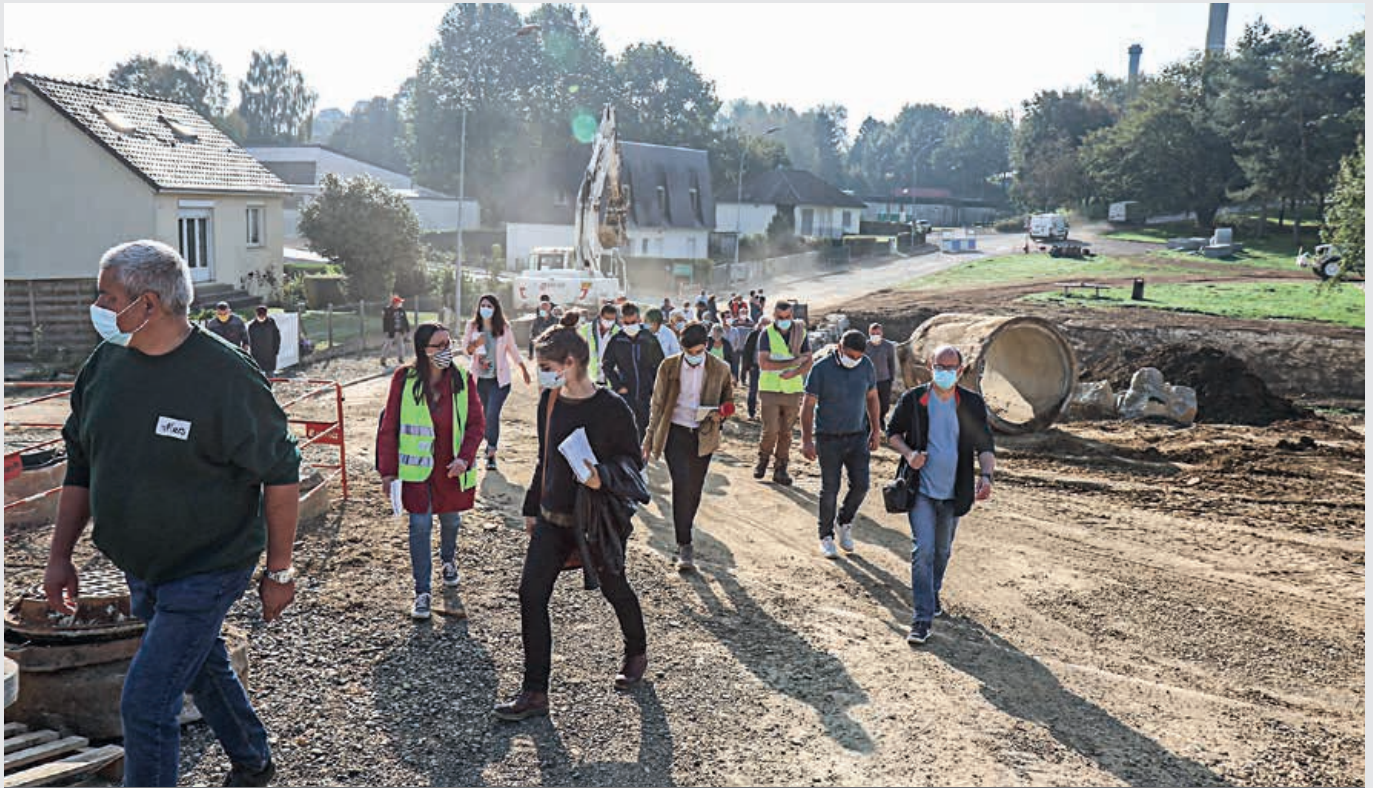
Des habitants ont été conviés à une visite du chantier de La Fouquerie, mardi 22 septembre.
