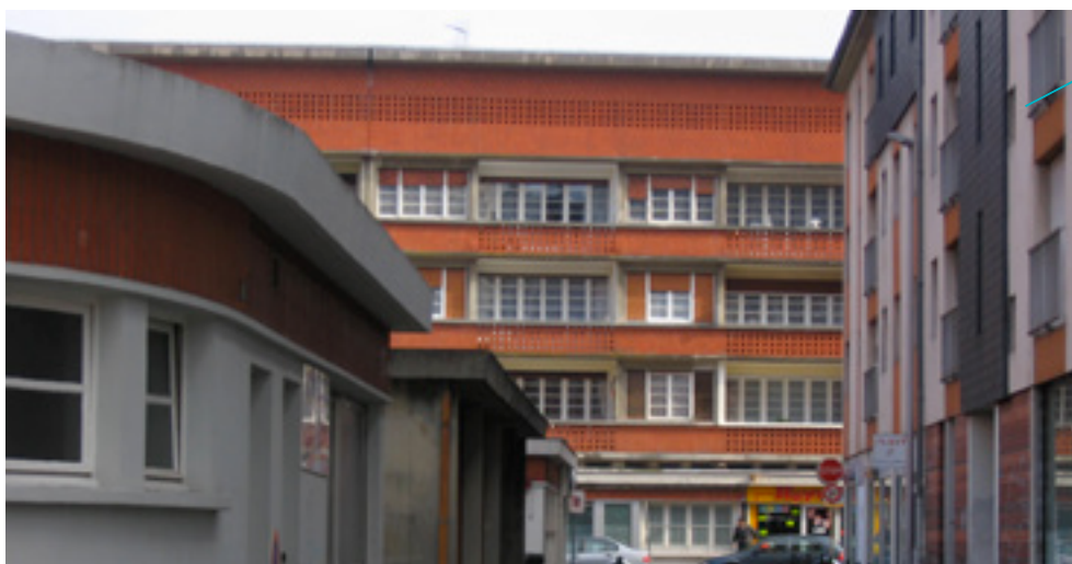
Figure 11 : Lisieux, IRP 25 rue du Hommet (Robert Camelot, architecte). L'immeuble est revêtu de briquette collée de même couleur que les immeubles de briques de la première partie de la Reconstruction.
