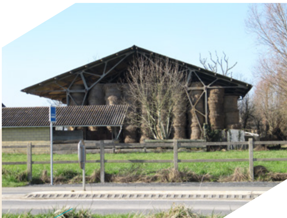
Figure 32 : Ferme à Merville (Calvados). Un exemple d'abri parapluie dont la charpente est formée par l'assemblage d'un seul type d'élément préfabriqué de forme triangulaire.
