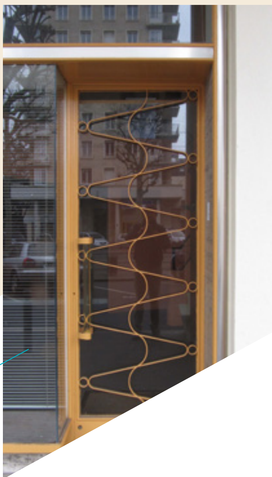
Figure 21 : Caen, porte d'une boutique avenue du Six-Juin (Pierre Dureuil, architecte chef de groupe).
