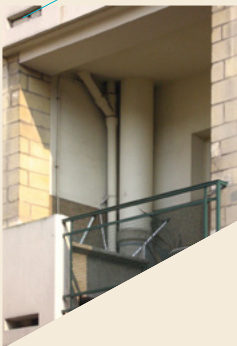
Figure 12 : Caen, loggia de service rue Jean Romain (Gilbert Vorbe, architecte). On distingue bien le bac à linge et le vide-ordure. La petite fenêtre qu'on devine à droite est celle de la salle de bains.
