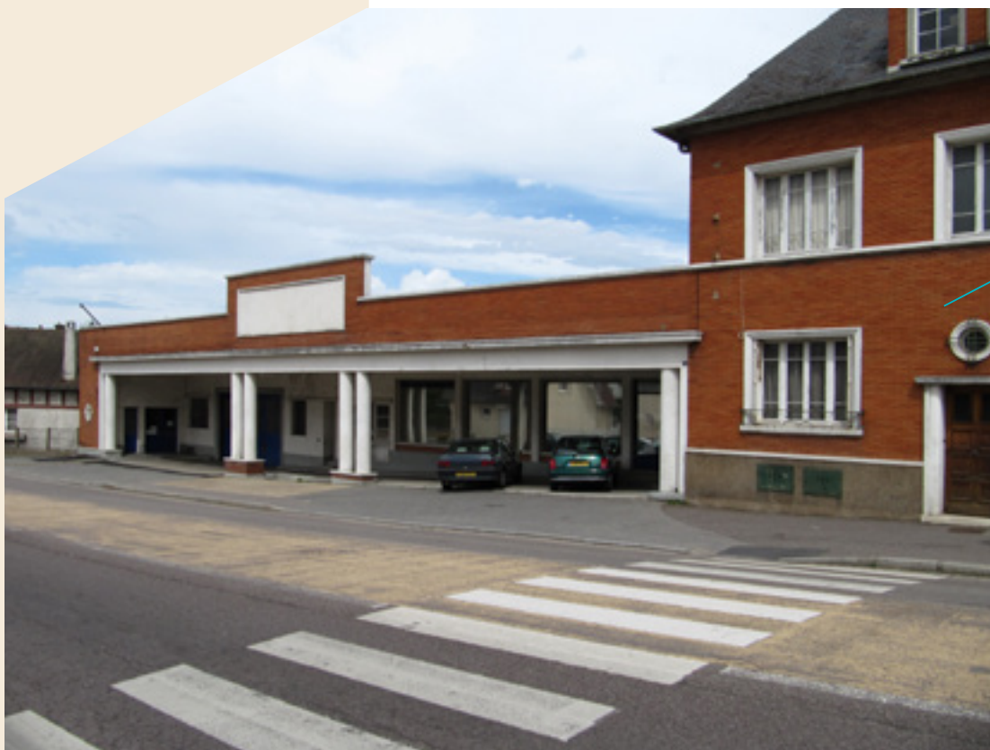
Figure 27 : Ancien garage à L'Aigle (Orne).
