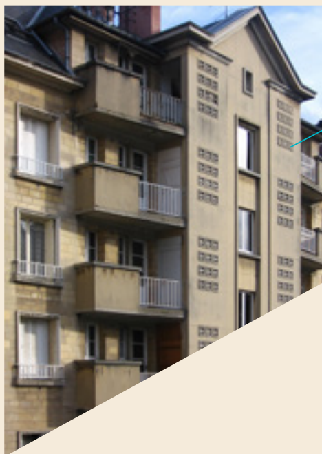
Figure 13 : Caen, IRP du Vaugueux (Ali Tur, architecte). L'ensemble est une variation de la loggia de service. La partie pleine des balcons cache le bac à charbon. La fenêtre qui le surmonte est celle de la salle de bains, la porte vitrée est celle de la cuisine, enfin le séchoir est aéré par une série de claustras. La fenêtre centrale de l'avant-corps éclaire un escalier.
