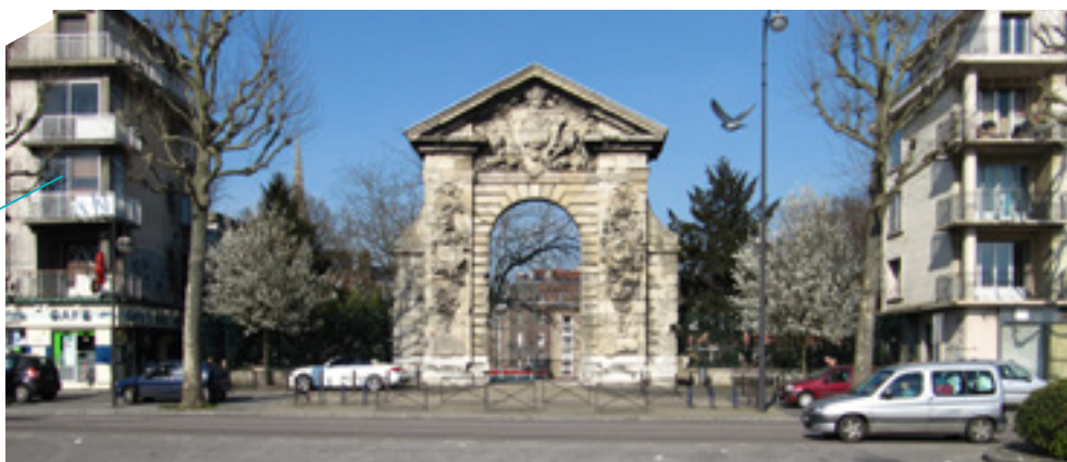
Figure 22 : Rouen, porte Guillaume Lion. Cette porte du XVIII e siècle a été démontée et reconstruite au niveau des quais hauts.
