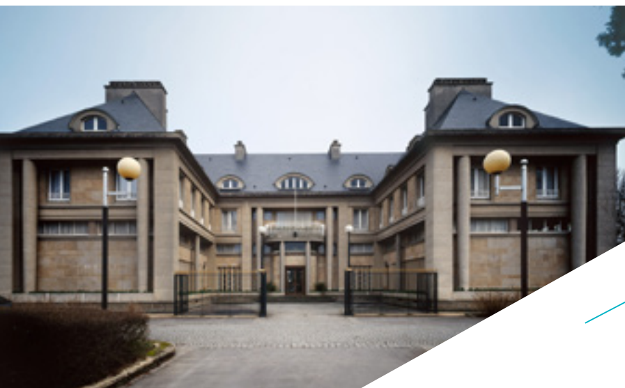
Figure 16 : La préfecture de Saint-Lô , (Louis Arretche, architecte) est bien représentative de la famille des constructions structurées, où l'ossature est mise en valeur. L'édifice témoigne de l'influence des réalisations d'Auguste Perret sur la Reconstruction [Région Normandie-Inventaire général Pascal Corbierre]
