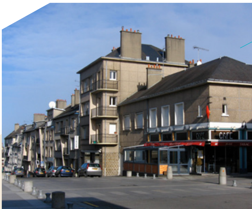
Figure 19 : Vire, place Castel (Jean-Louis Humbaire, architecte). Les toits à faible pente, inhabitables, font le lien avec les toitures plus traditionnelles à forte pente du reste de la Reconstruction.
