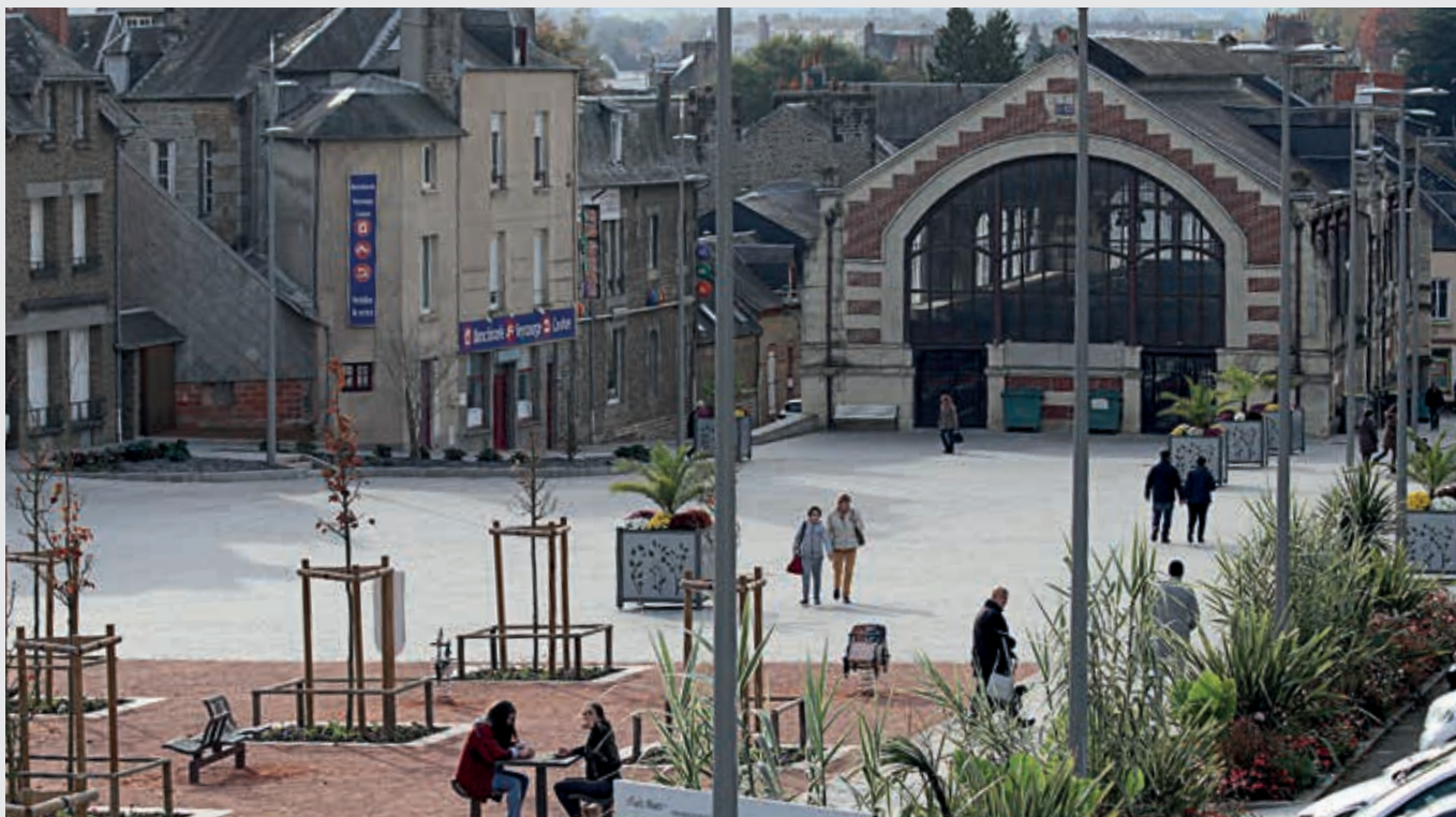
En 2018, la Ville de Flers va rénover le marché couvert et mettre en lumière l'édifice qui date de 1883. Ce chantier s'accompagnera de la mise en lumière de l'église Saint-Germain.
