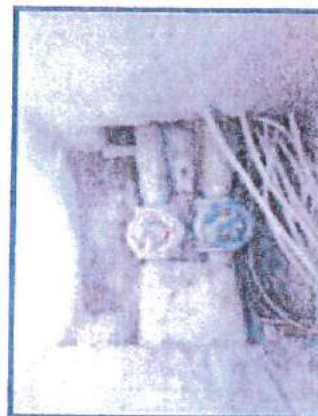
Photo 45 : Vannes à opercule
