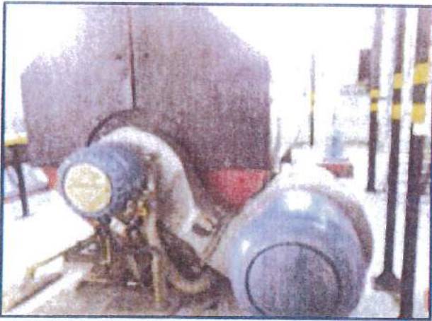
Photo 3 : Chaudière fioul lourd en service pour le secours
