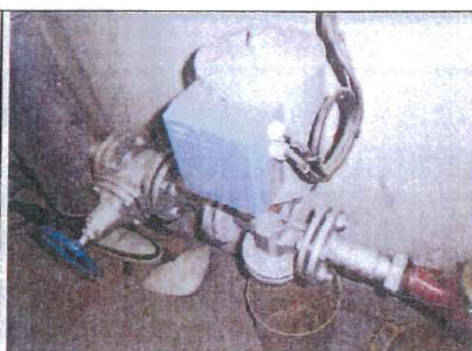
Vanne de régulation chauffage
