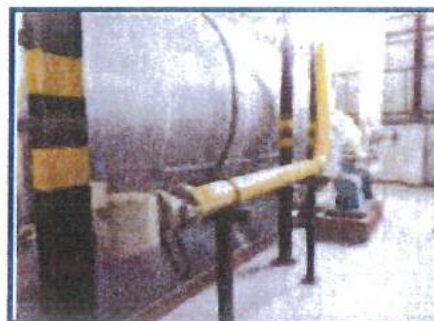
Photo 21 : Une vanne de barrage gaz par chaudière
