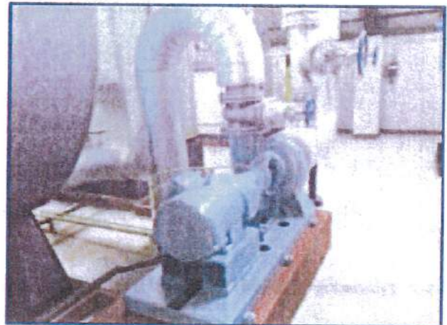
Photo 6 : Une pompe de recyclage par chaudière
